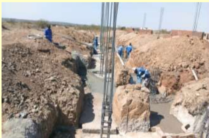
Die Fundamente werden ohne schweres Gerät von Hand mit Spaten und Pickel gegraben – Juli 2018
