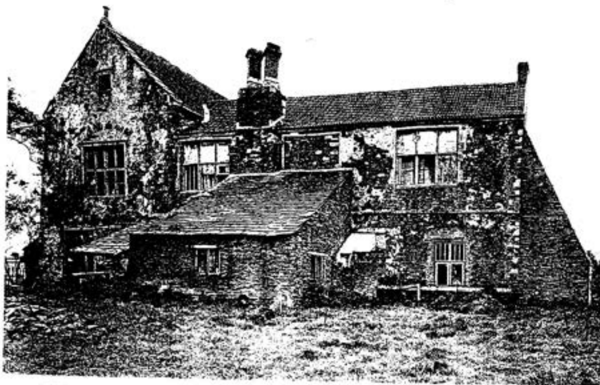
Blick von außen auf den Nordflügel und den Giebel des Ostflügels
