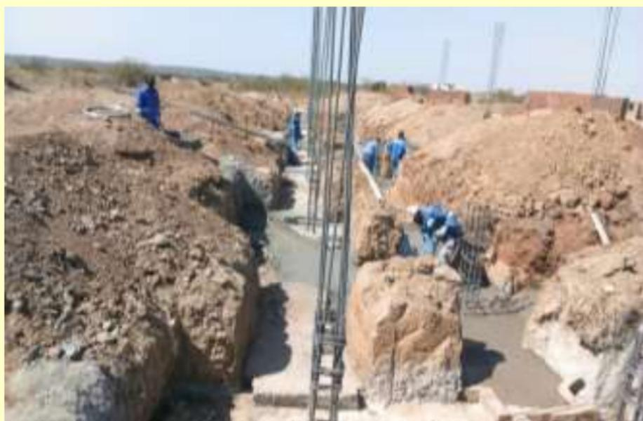
Die Fundamente werden ohne schweres Gerät von Hand
